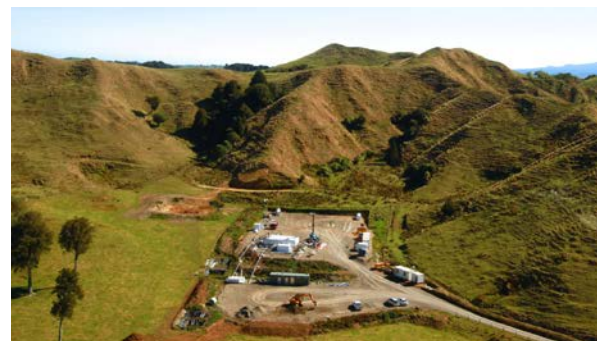
Figure 2. Existing Puka A well pad (Puka-1 & Puka-2).
